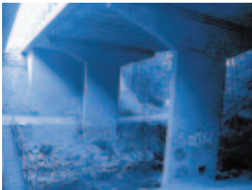
Siggernbrücke Attiswil BE
